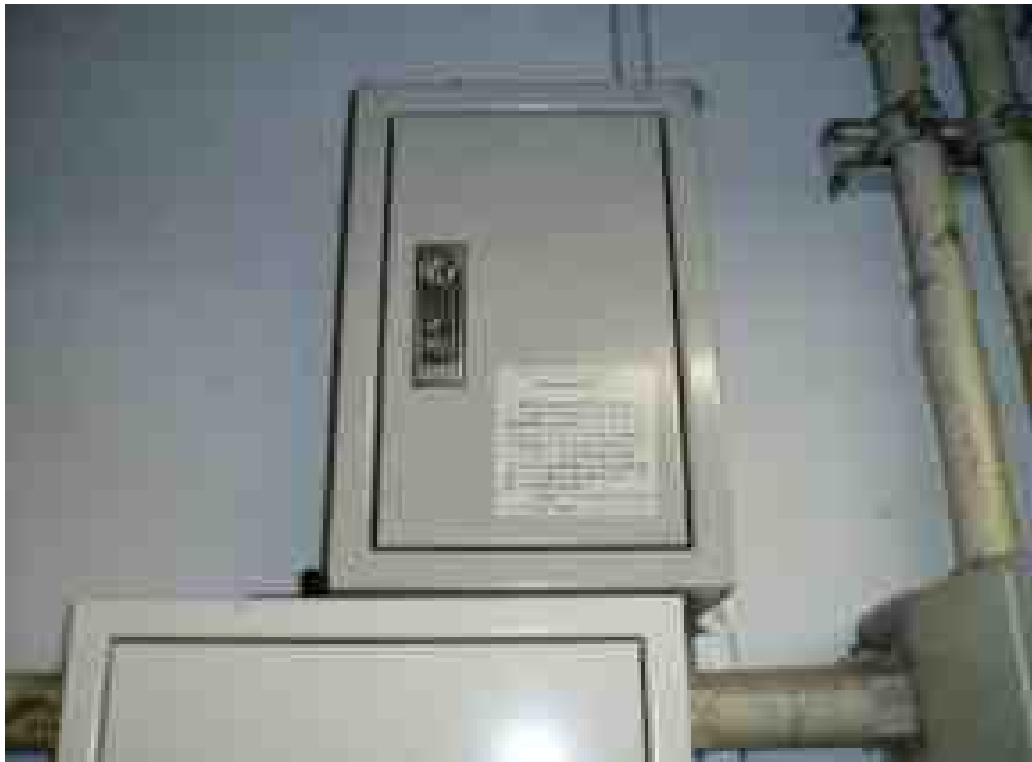
(ナースコール用非常電源ボックス)
